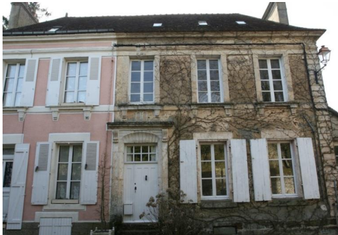
Ce bâtiment XVIII e a sans doute perdu ses menuiseries d'origine qui devait être à petit bois à l'image de la porte d'entrée. Dans ce même bâtiment, les fenêtres de l'étage ont une répartition différente des petits bois.
