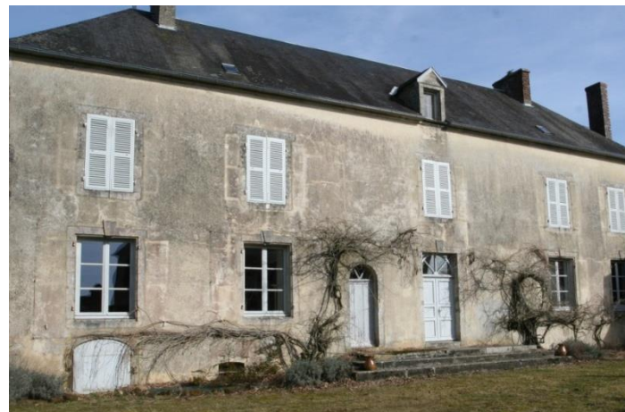
Ce bâtiment début XVIII e siècle a perdu ses menuiseries d'origine, ce qui donne aux baies une composition de petits bois peu satisfaisante.
