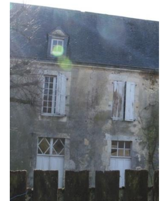
Bâtiment ayant conservé ses menuiseries d'origine ; fenêtres et porte avec imposte.
